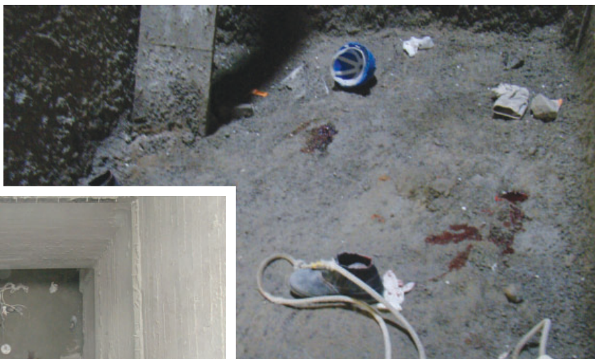
O ajudante de pedreiro Maurílio Damasceno despencou de uma altura de 21 metros
